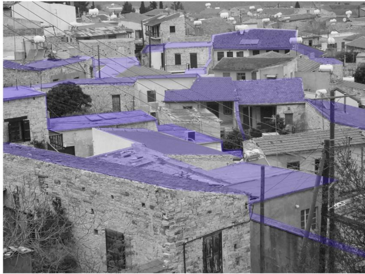
Στην πιο πάνω πανοραμική φωτογραφία φαίνεται το δίκτυο διακίνησης στα δώματα του χωριού και οι εναλλαγές βατών επιφανειών.
